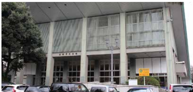
安全性向上を図る高岡市民会館
