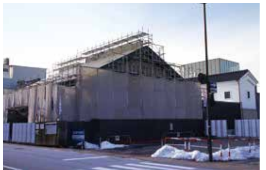
観光の重要施設として整備が進む高岡御車山会館
