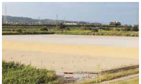
整備が進む牧野河川公園
