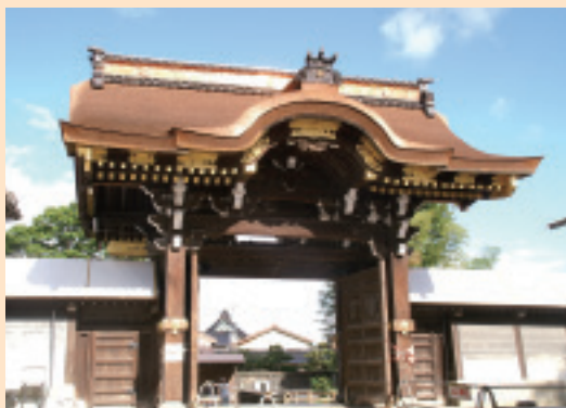
見事に復元された檜皮葺屋根の勝興寺唐門
