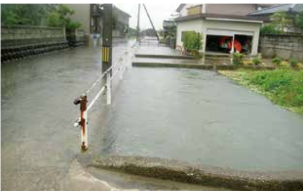
河川改修による浸水被害対策を
