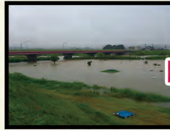
大雨で水没、 その後の復旧作業 (平成25年8月)
