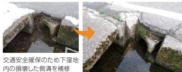
交通安全確保のため下窪地内の損壊した側溝を補修
