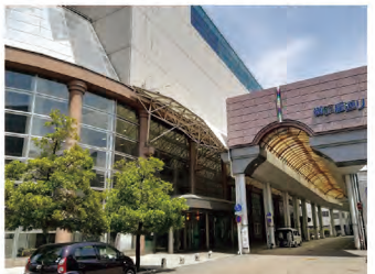
都市機能を集積していく中で、キーテナントが撤退し、早急な対応が求められる高岡駅周辺ゾーン内の「御旅屋セリオ」
