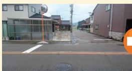
車両通行時に生じる騒音・振動を解消し、住環境を改善するため、路面とマンホールの段差を解消する道路改修を実施
