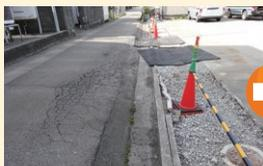
損傷の激しかった道路を改修すると共に、雨水排水機能の向上のため側溝を整備
