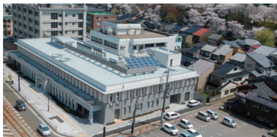
高岡市急患医療センター(屋上に太陽光発電システムが整備された)
