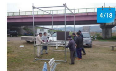
4/18 国条橋パークゴルフ場にトイレを設置
