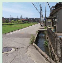
児童の通学路沿いの用水(幅が広く、開渠となっている)
